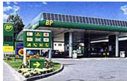
Station essence à énergie solaire
